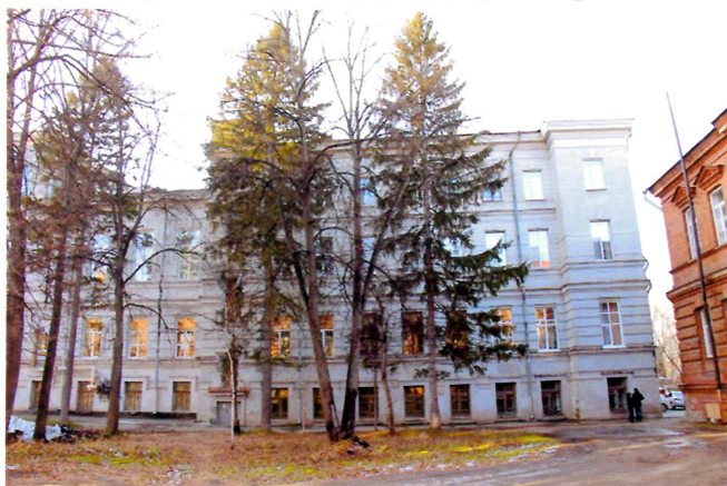
Видовая точка № 57. Дворовой жилой корпус. Восточный фасад.
