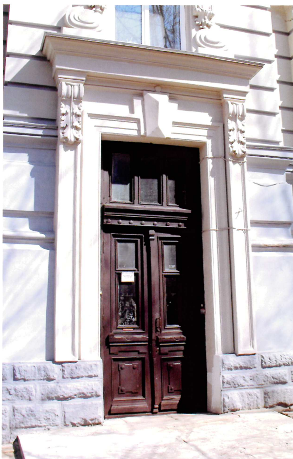
Видовая точка № 51. Северный жилой корпус. Парадный вход.
