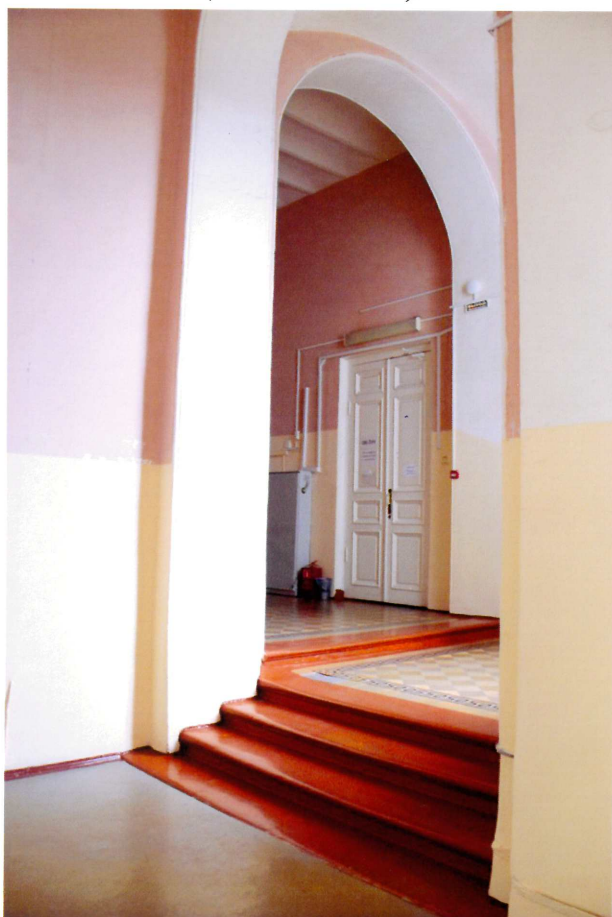
Видовая точка № 25. Учебный корпус. Фрагмент коридора 2-го этажа.
