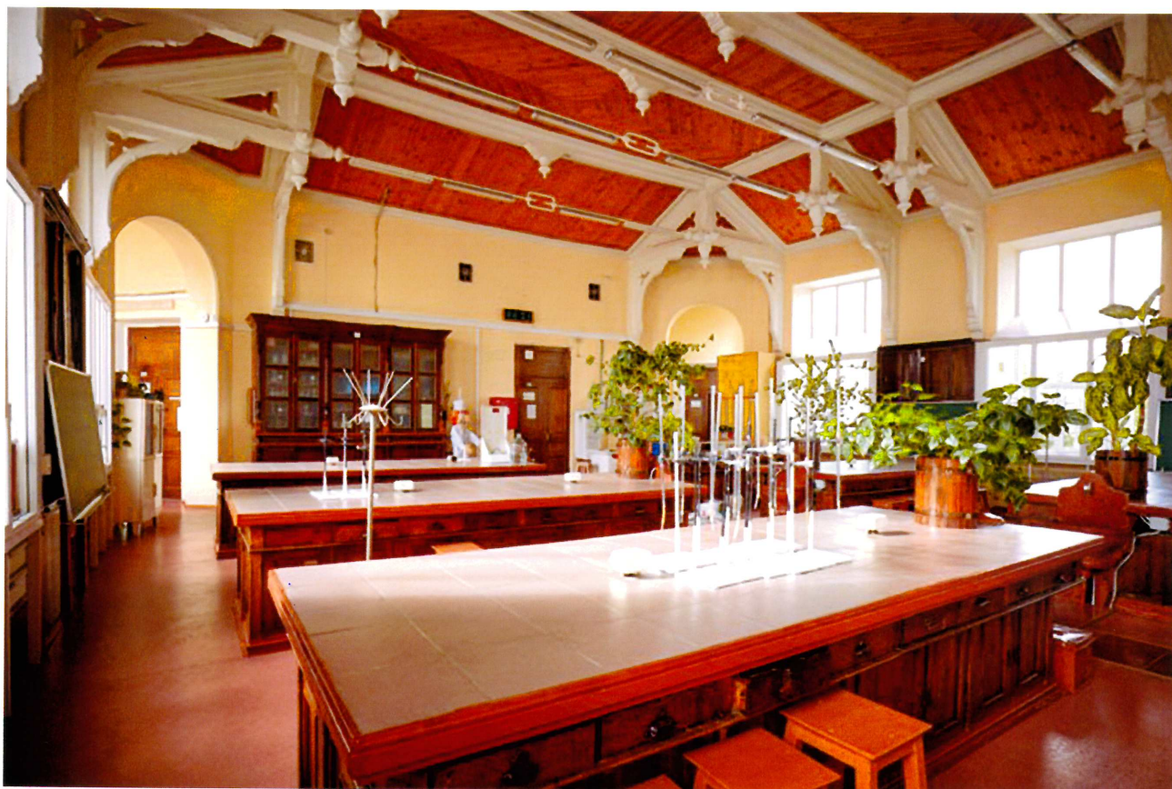
Видовая точка № 29. Учебный корпус. Интерьер лаборатории с встроенной мебелью. Деревянные фермы в конструкции перекрытий. Автор съемки: Максим Печерский, дата: апрель, 2016 г.
