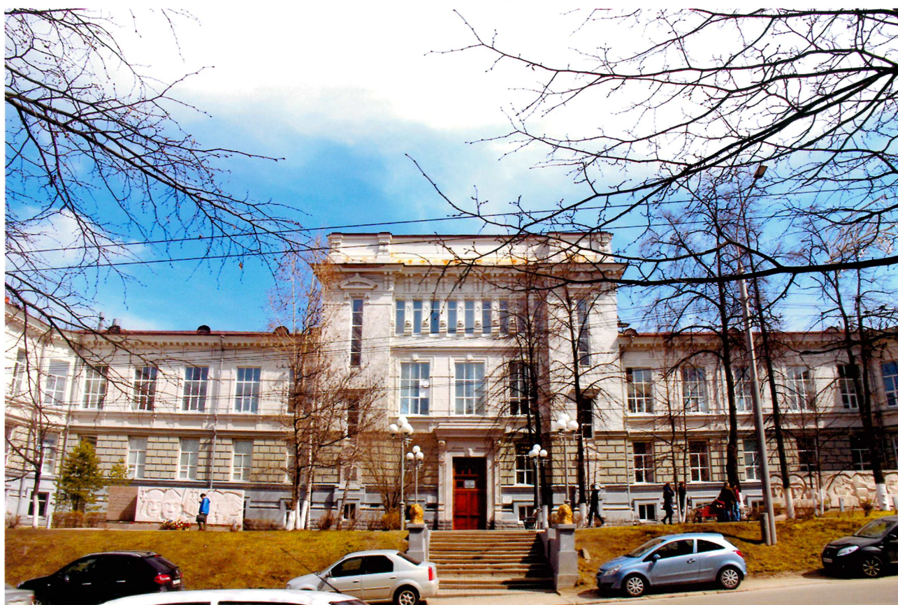
Видовая точка № 2. Главный фасад учебного корпуса. Центральная часть. Вид с пр. Ленина.
