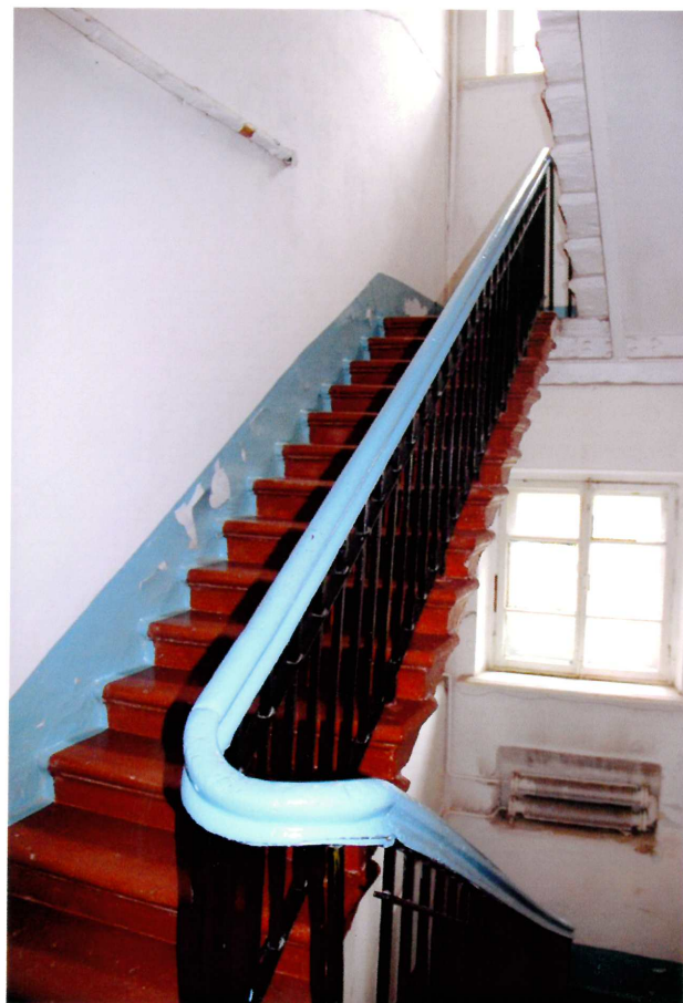
Видовая точка № 73. Жилой (южный) корпус. Служебная лестница с простым кованым ограждением.
