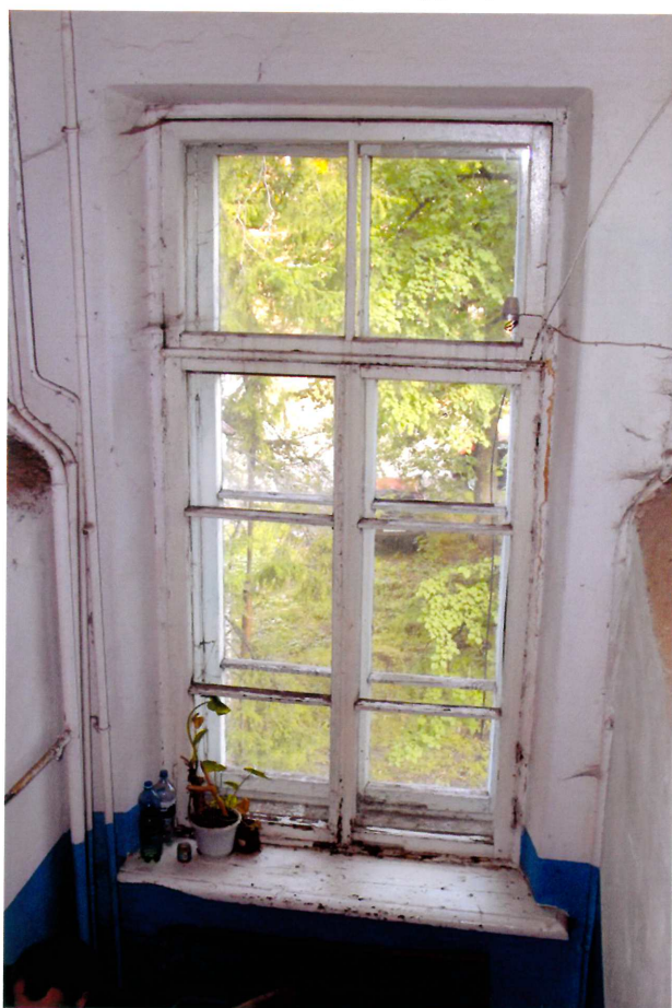
Видовая точка № 66. Жилой корпус. Деревянное оконное заполнение с деревянным подоконником. Лестничный блок.
