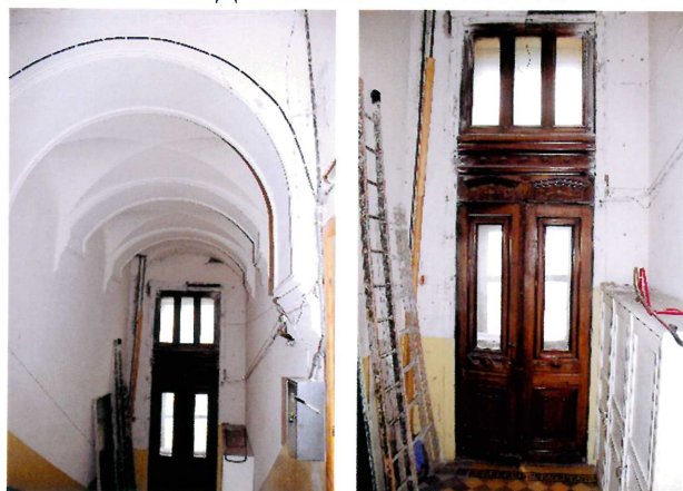
Видовые точки № 61, 62. Жилой (южный) корпус. Вестибюль. Внутренние двери парадного входа. Дата съемки: 14.08.2014 г.
