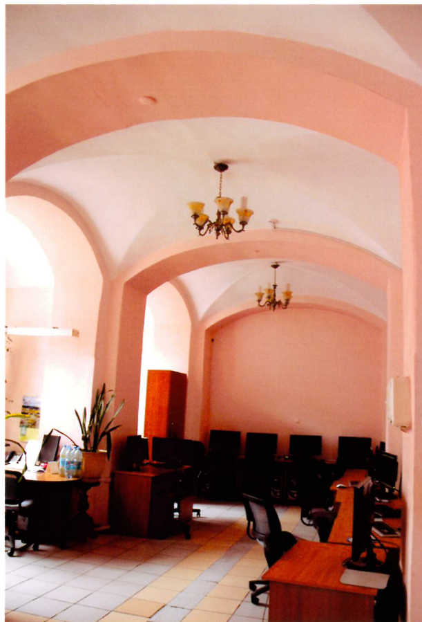
Видовая точка № 19. Учебный корпус. Фрагмент помещения 1-го этажа (дворовой объем).
