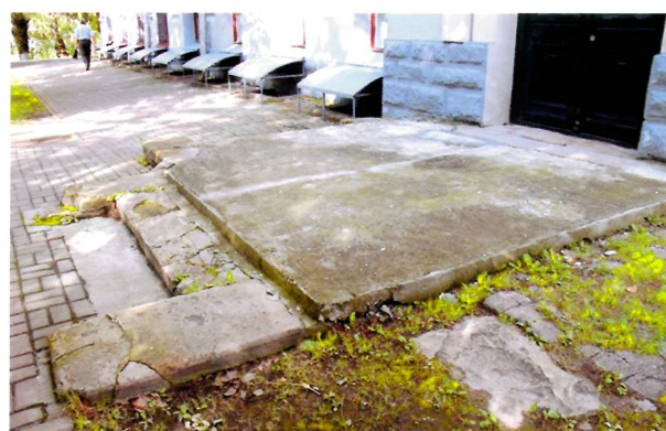
Видовая точка № 52. Северный жилой корпус. Крыльцо парадного входа из песчаника. Дата съемки: 03.08.2015 г.
