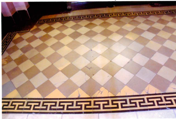
Видовая точка № 39. Учебный корпус. Покрытие пола из метлахской керамической плитки, ее рисунок. Тамбур парадного входа.
