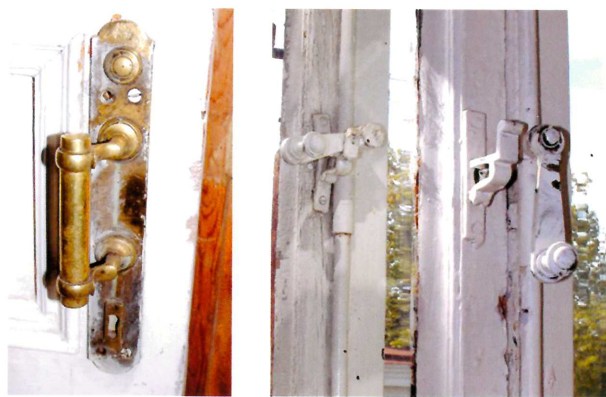
Видовые точки № 67, 68. Жилой корпус. Латунная дверная ручка с клеймом производителя. Скобяная фурнитура окна.
