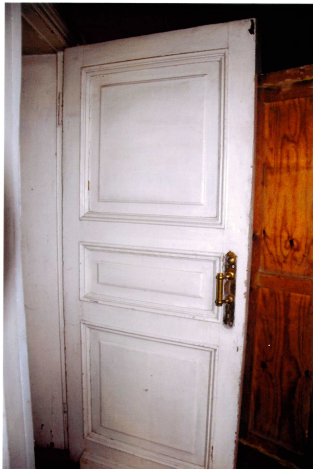
Видовая точка № 65. Жилой корпус. Деревянная филенчатая дверь с фурнитурой.
