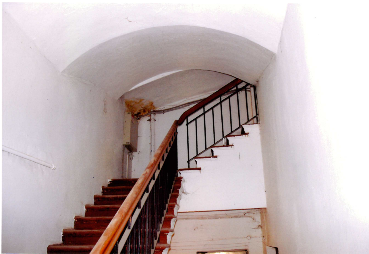
Видовая точка № 74. Жилой (восточный) корпус. Центральная лестница. Кирпичный свод.
