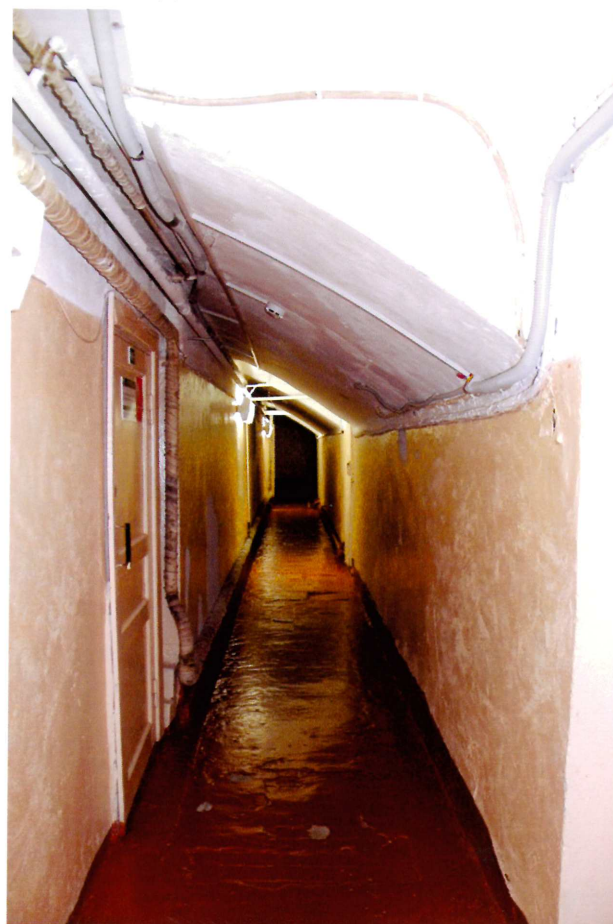
Видовая точка № 13. Учебный корпус. Фрагмент цокольного этажа. Коридор. Дата съемки: 14.08.2014 г.
