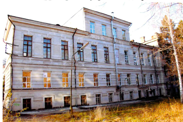
Видовая точка № 11. Учебный корпус. Дворовой (восточный) фасад. Дата съемки: 20.10.2014 г.
