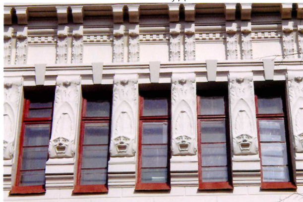
Видовая точка № 5. Учебный корпус. Центральная часть главного фасада. Первоначальный вид расстекловки окон 3-го этажа. Декор простенков и карниза. Автор снимка: Яблонская М.А., дата: 12.05.2004 г.
