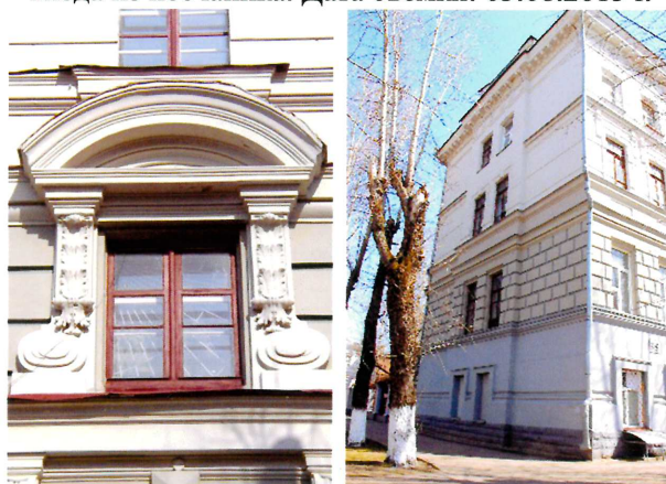
Видовая точка № 53,54. Северный жилой корпус. Декор и первоначальный вид расстекловки окна (над парадным входом). Автор снимка: Яблонская М.А., дата: 12.05.2004 г. Северный фасад (торец).
