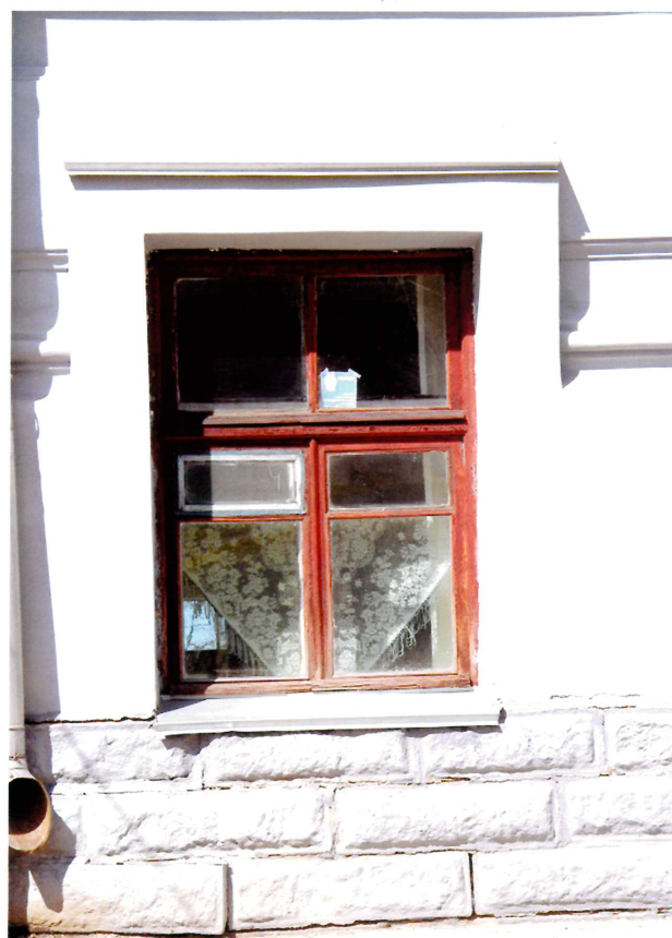
Видовая точка № 7. Учебный корпус. Главный фасад. Окно цокольного этажа.
