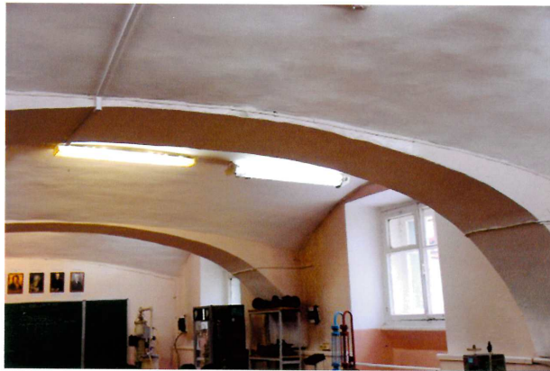
Видовая точка № 14. Учебный корпус. Фрагмент помещения цокольного этажа.
