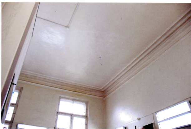
Видовая точка № 23. Учебный корпус. Фрагмент помещения 2-го этажа (восточная часть).
