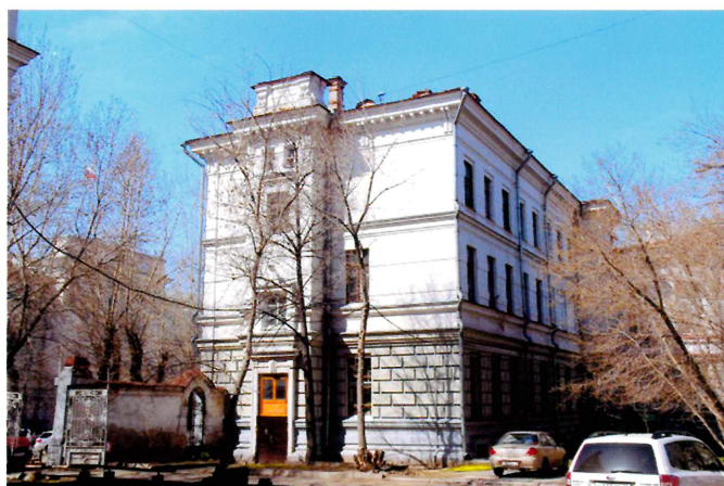
Видовая точка № 49. Торец южного жилого корпуса.
