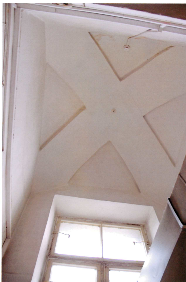
Видовая точка № 24. Учебный корпус. Фрагмент помещения 2-го этажа (восточное крыло). Свод над «косым» переходом.
