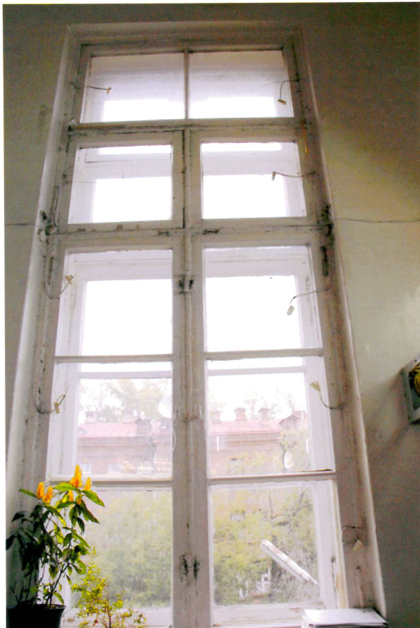
Видовая точка № 41. Учебный корпус. Деревянное оконное заполнение 2-го этажа. Восточная часть.
