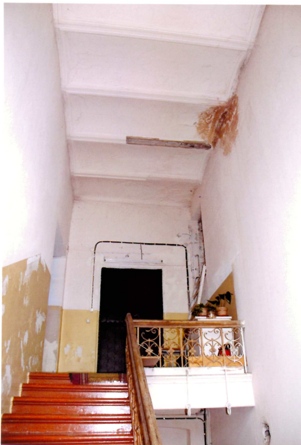
Видовая точка № 72. Жилой (южный) корпус. Парадная лестница с кованым ограждением растительного орнамента. Кирпичные своды.
