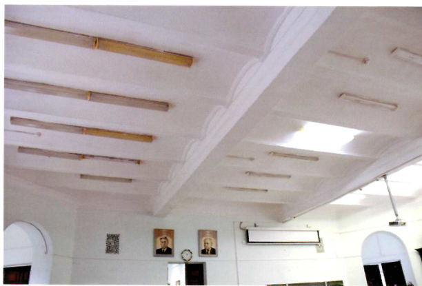
Видовая точка № 22. Учебный корпус. Фрагмент помещения 2-го этажа (дворовой объем).
