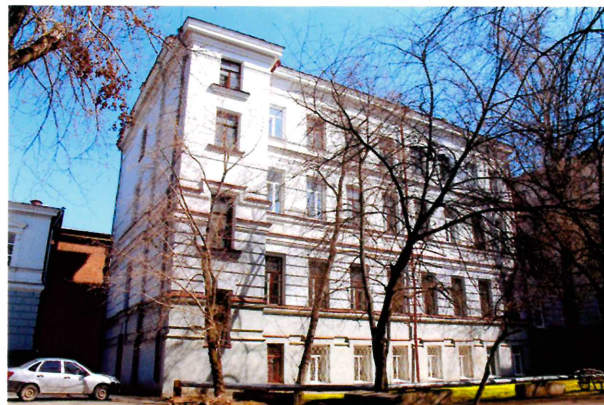
Видовая точка № 56. Дворовой жилой корпус. Западный фасад.
