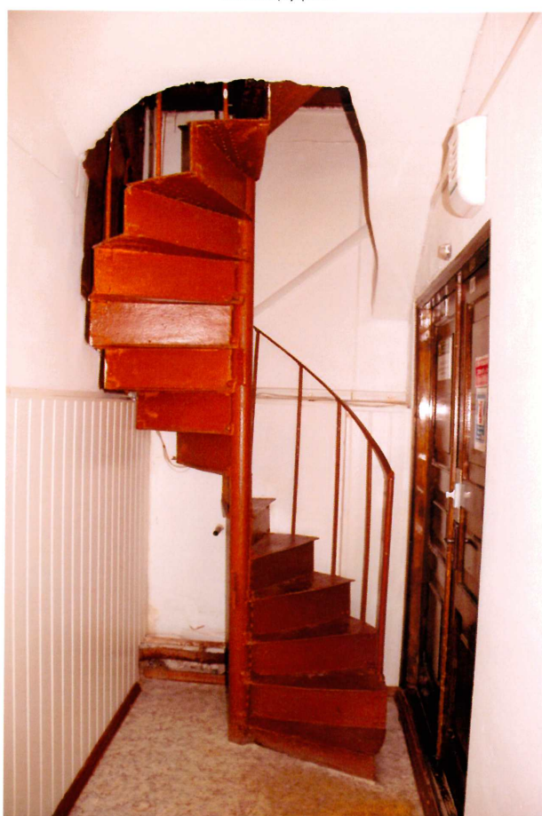
Видовая точка № 37. Учебный корпус. Винтовая лестница с кованым ограждением. Цокольный этаж южного крыла.
