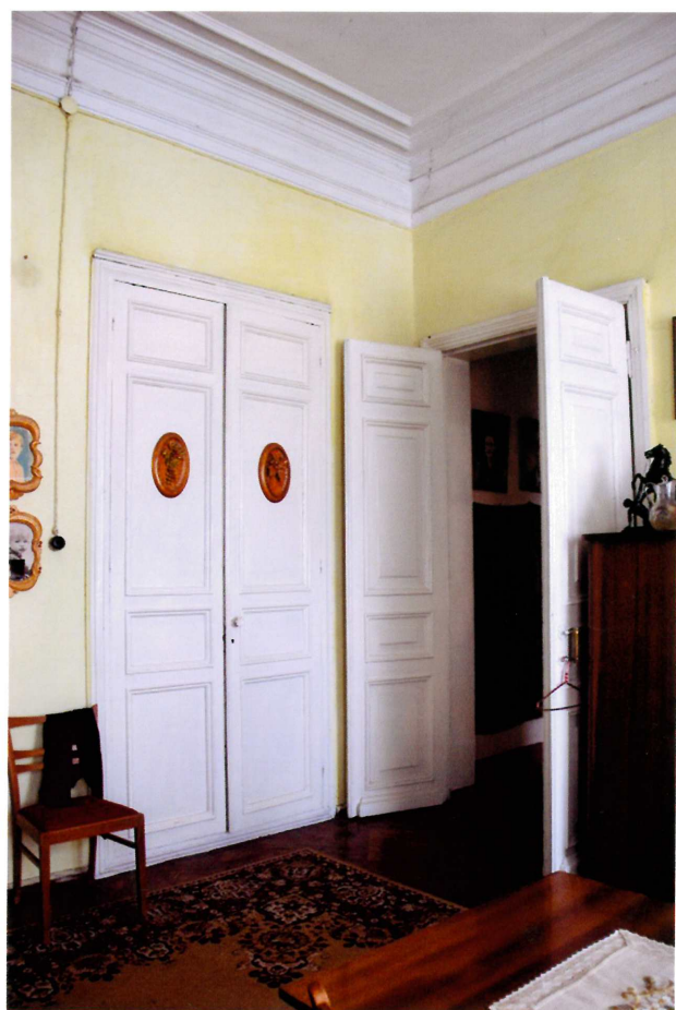
Видовая точка № 63. Жилой корпус. Интерьер квартиры 3-го этажа. Деревянные филенчатые двери. Профильные тяги.
