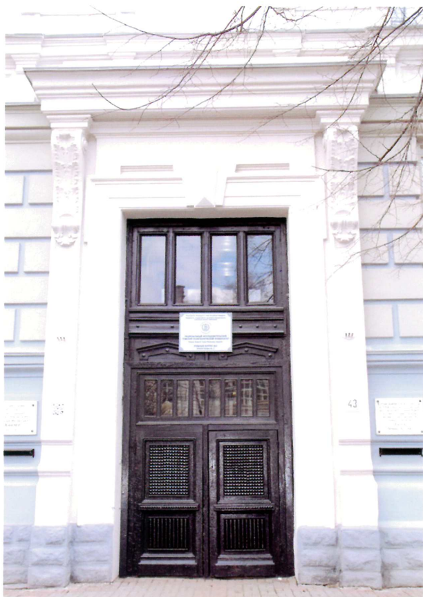
Видовая точка № 6. Учебный корпус. Парадный вход главного фасада и его декор. Первоначальный вид дверей. Автор съемки: Яблонская М.А., дата: 22.04.2015 г.
