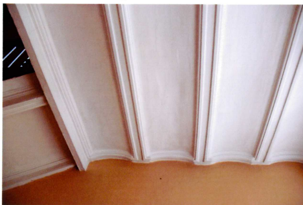
Видовая точка № 35. Учебный корпус. Кирпичные своды в конструкции лестничных площадок.
