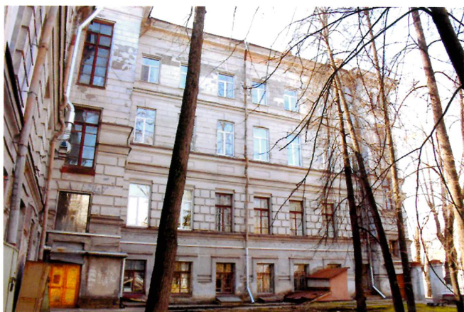
Видовая точка № 55. Северный жилой корпус. Дворовой фасад.
