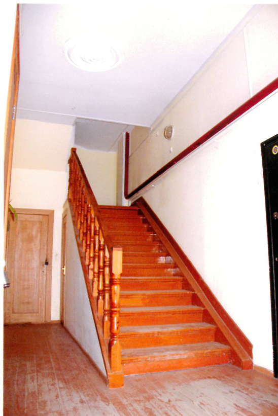
Видовая точка № 25. Лестница парадного входа после ремонта ступеней и установки нового ограждения.
