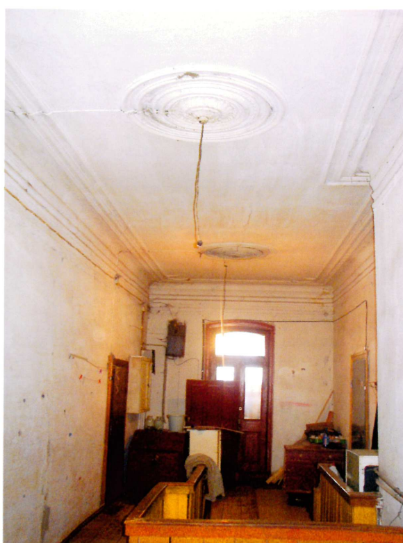
Видовая точка № 27. Фрагмент интерьера помещения центральной лестницы (2-й этаж).
