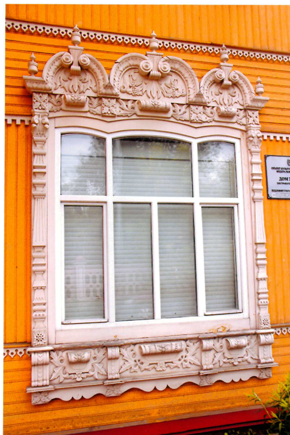
Видовая точка № 15. Окно 1-го этажа южного фасада с наличником, изготовленным по образцу.
