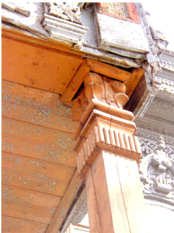
Видовая точка № 16. Фрагмент подлинной колонны веранды южного фасада.
