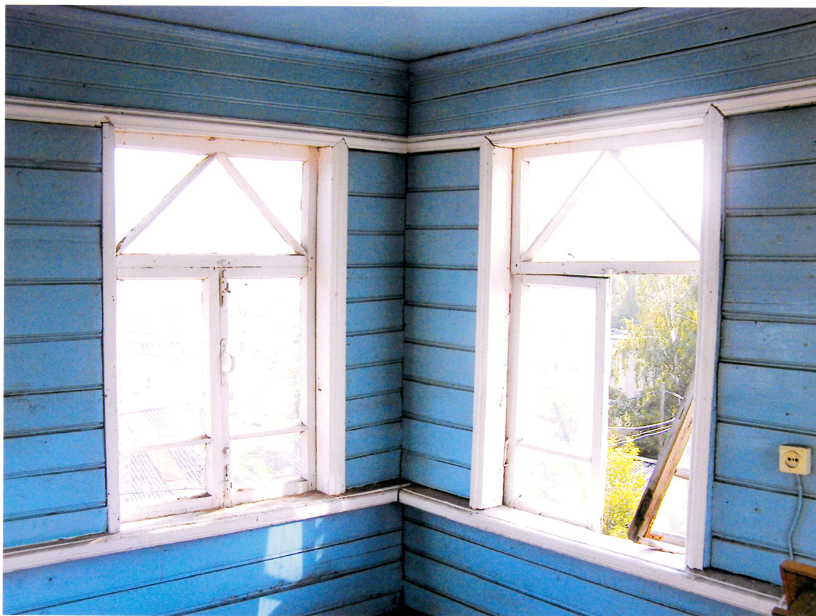
Видовая точка № 31. Помещение мезонина. Профильная обшивка стен, элементы декора, окна (Автор снимка: Калайда Т.В., дата съемки: 2009 г.)
