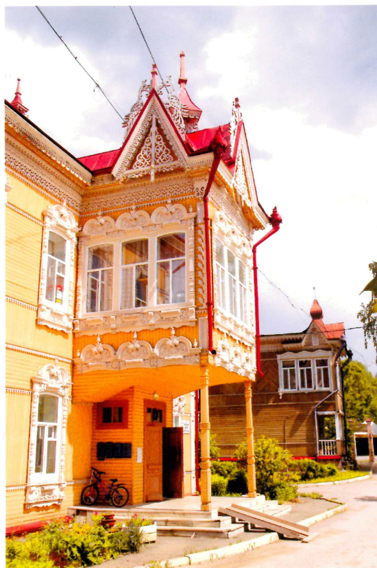
Видовая точка № 4. Веранда южного фасада (после реставрации).
