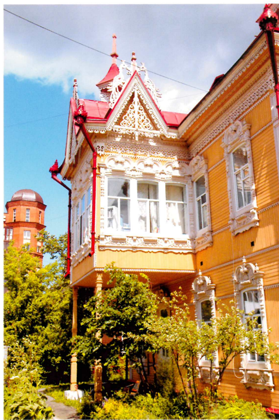
Видовая точка № 6. Веранда западного фасада (после реставрации).
