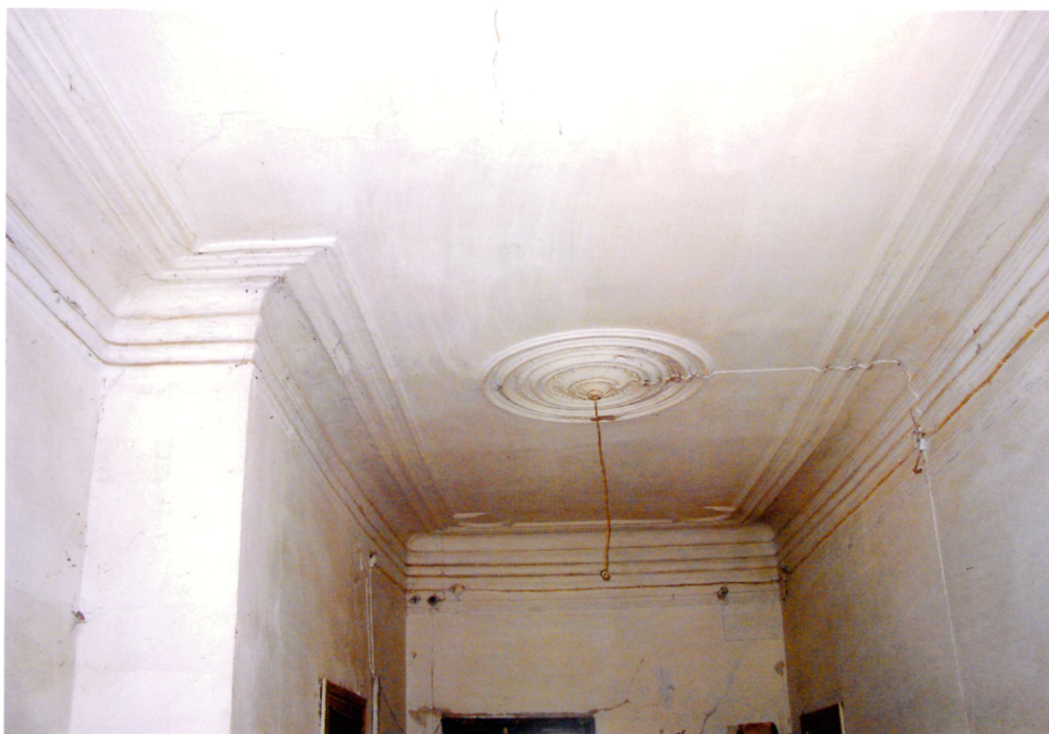
Видовая точка № 29. Штукатурный декор потолка помещения центральной лестницы (2-й этаж).
