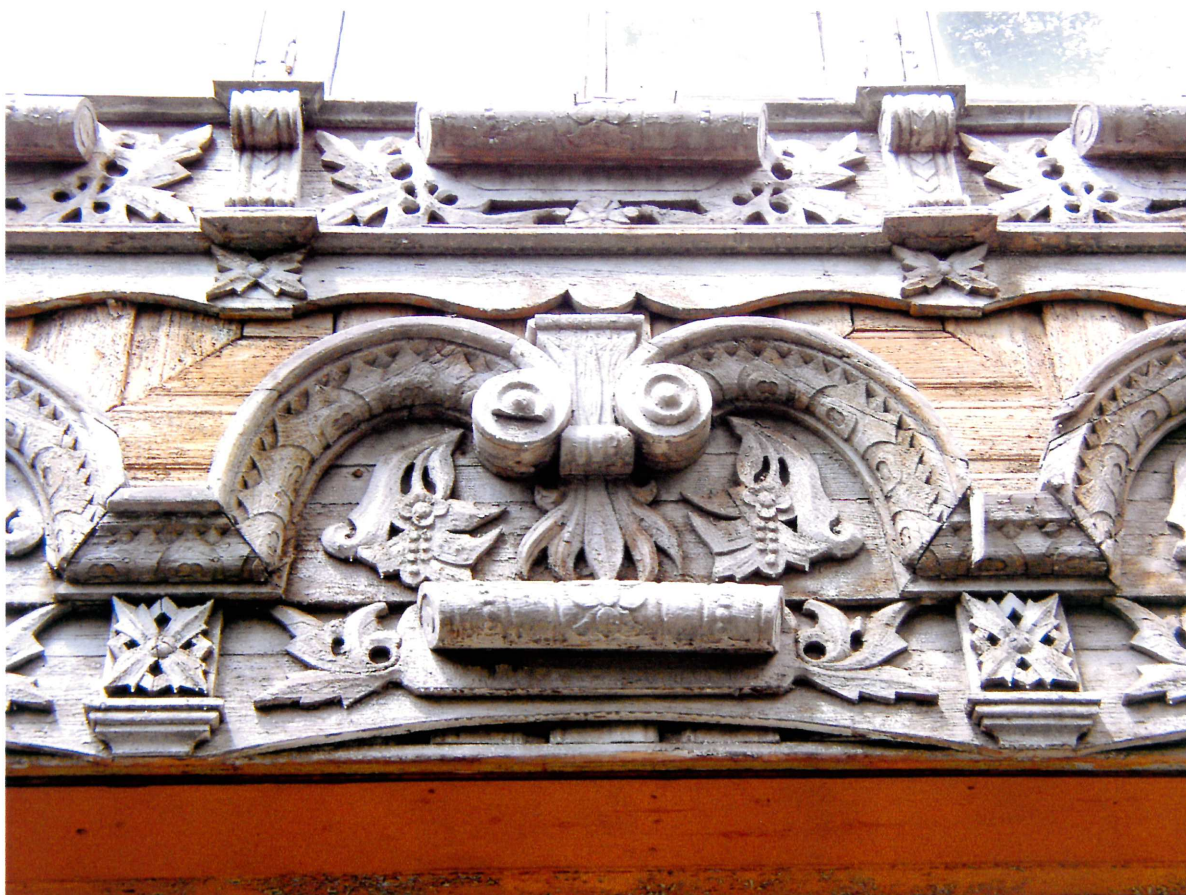
Видовая точка № 10. Фрагмент декора веранды южного фасада (до реставрации).
