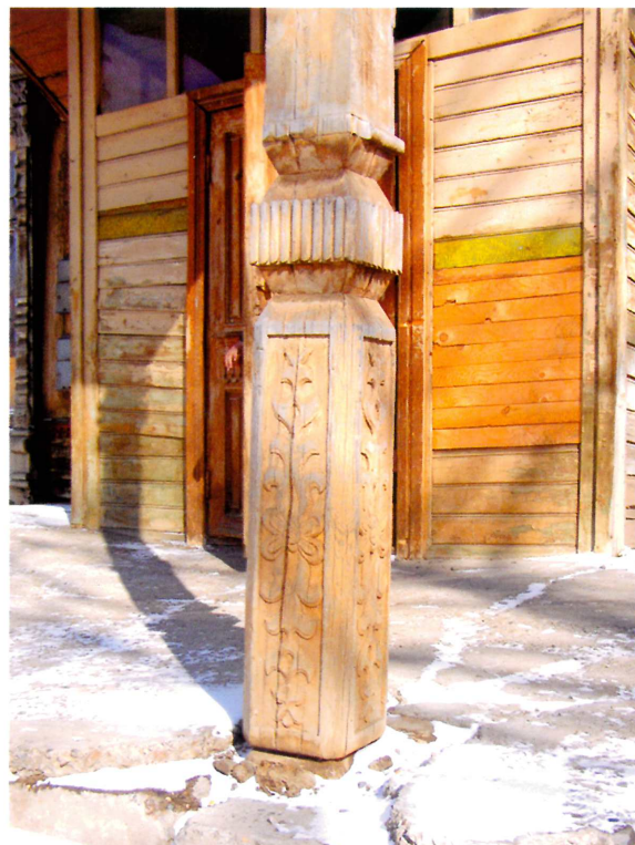
Видовая точка № 17. Фрагмент подлинной колонны веранды южного фасада.
