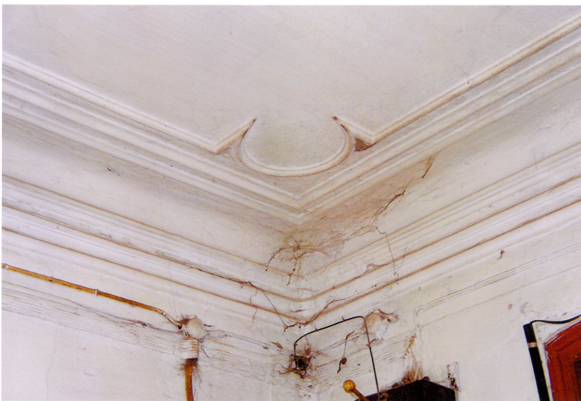
Видовая точка № 29. Помещение центральной лестницы (2-й этаж). Профильные штукатурные тяги с элементами декора потолка.
