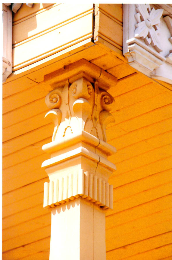
Видовая точка № 18. Фрагмент колонны веранды южного фасада (изготовлена по образцу).
