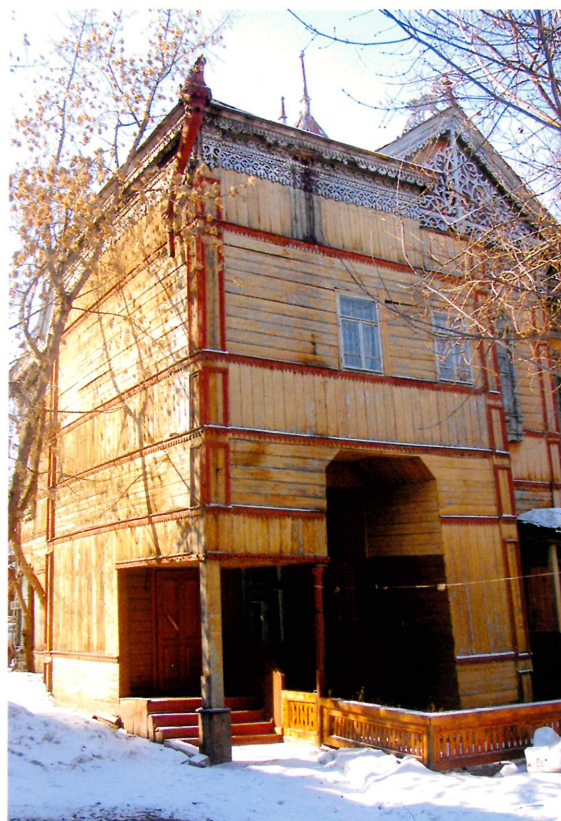
Видовая точка № 8. Пристройка лестничного блока северного фасада (до реставрации, 2004 г.).
