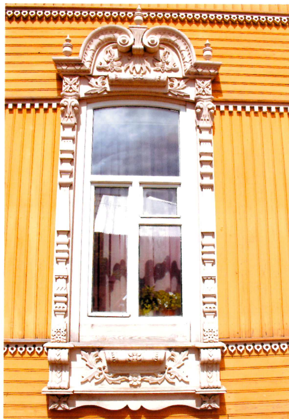
Видовая точка № 13. Окно 1-го этажа южного фасада с наличником, изготовленным по образцу.
